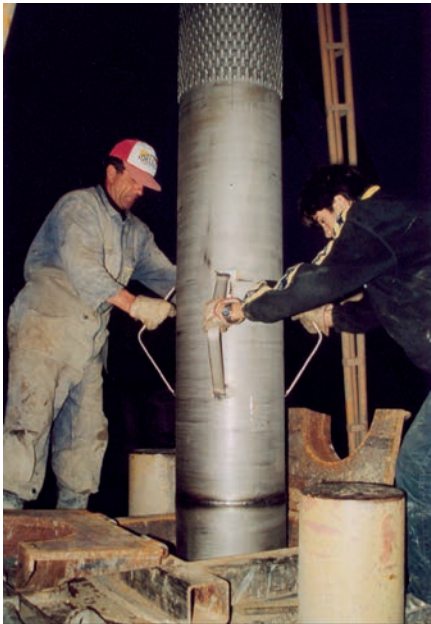
Fig. 15 - Immagine durante la fase di inserimento della colonna munita di centratori (da IDROGEO).
