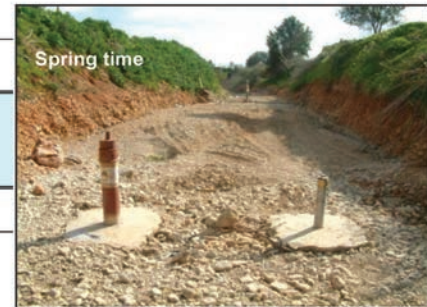
Fig. 4 - Design configuration of the two infiltration basins in the river bed of Rio Seco (at Carreiros), winter time and spring time photos. Fig. 4 - Schema dei due bacini di infiltrazione nel letto del Rio Seco (a Carreiros), nelle foto il periodo invernale e primaverile.
