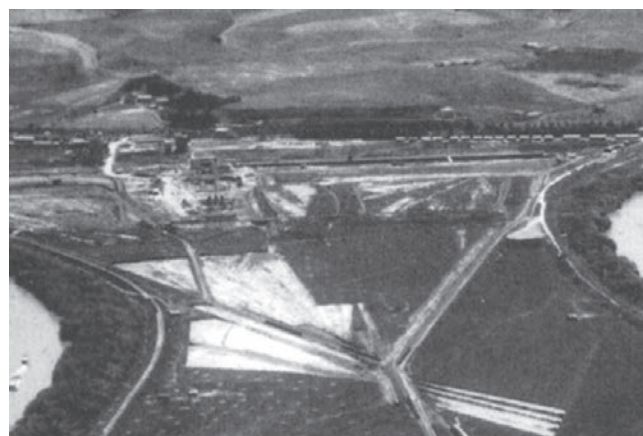
Fig. 1: Il Drizzagno di Spinaceto, visto da Ovest, durante i lavori di scavo; ai lati della foto visibile il meandro ostiense (foto di pubblico dominio, arvaliastoria.it). Fig. 1: Western view of the Spinaceto riverbed rectification during the excavation works; on both sides of the picture is visible the Ostiense meander (public domain, arvaliastoria.it).
