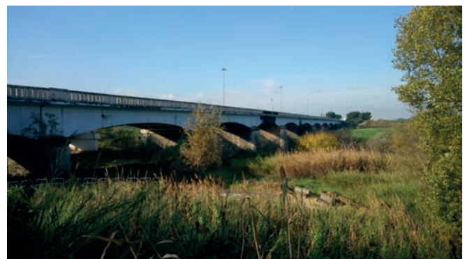
Fig. 4: Il Ponte di Mezzocammino, oggi.
