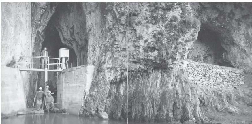
Fig. 5 - Panoramica della stazione idrometrografica nel marzo 1974, con gli artefici del manufatto al termine dell'impresa (sulla passerella Gianfranco Ciancetti, in basso a sinistra Antonio Piccoli e Settimio Reali, in posizione arretrata Ennio Pepa; foto di Paolo Bono).
