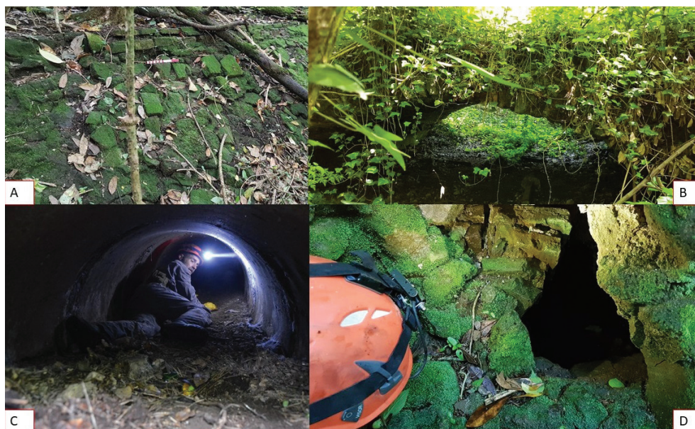
Fig. 4 - Le vestigia dell'antico lago: A) una delle scogliere artificiali; B) ponticello rustico che divideva in due il lungo lago; C) esplorazione del condotto idrico moderno in cemento; D) il piccolo condotto ipogeo nella diga del bacino superiore.
