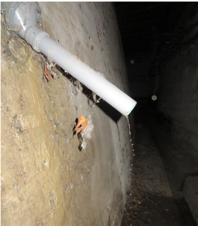
Fig. S11 - Fessure sul muro difensivo del complesso (fotografia scattata nel marzo 2024).
