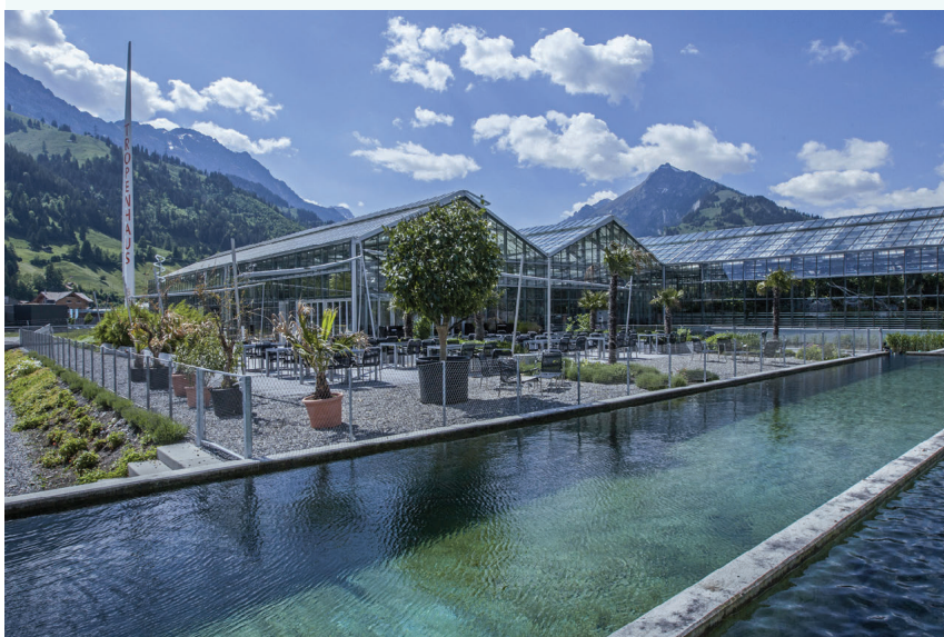
Fig. 17 - Progetto Tropenhaus: esempio di utilizzo per scopi produttivi dell'acqua naturalmente calda intercettata dalla galleria ferroviaria.
