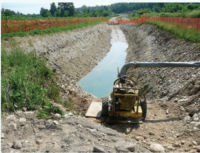
Fig. 8 - Prova di emungimento (sinistra) in trincea di sottopasso stradale, finalizzata al dimensionamento dell'impianto di drenaggio necessario in fase di cantiere e delle modificazioni permanenti indotte dall'opera sul regime della falda e dei fontanili di pianura. Rappresentazione di un modello di scenario (destra) sviluppato a supporto del processo decisionale per la scelta della soluzione definitiva: lo scenario è relativo all'abbattimento della falda in corso d'opera mediante lo schema di aggotamento progettato.
